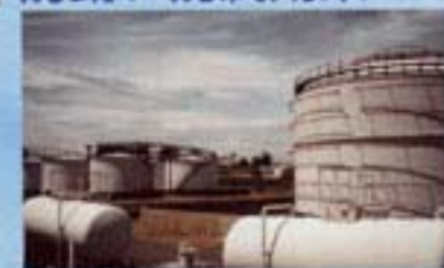
石油タンクでの防錆、防腐、断熱工程
