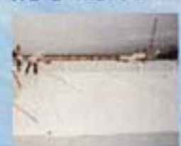
屋根での防水断熱工程
